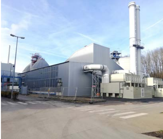
Heizkraftwerk, Bayern, Deutschland
