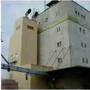
Deutschland / Germany MDB-TN 2/14 Kapazität / capacity: 100 t/h 19% -> 15% (Getreide/wheat) 25 t/h 35% -> 15% (Mais/maize)
